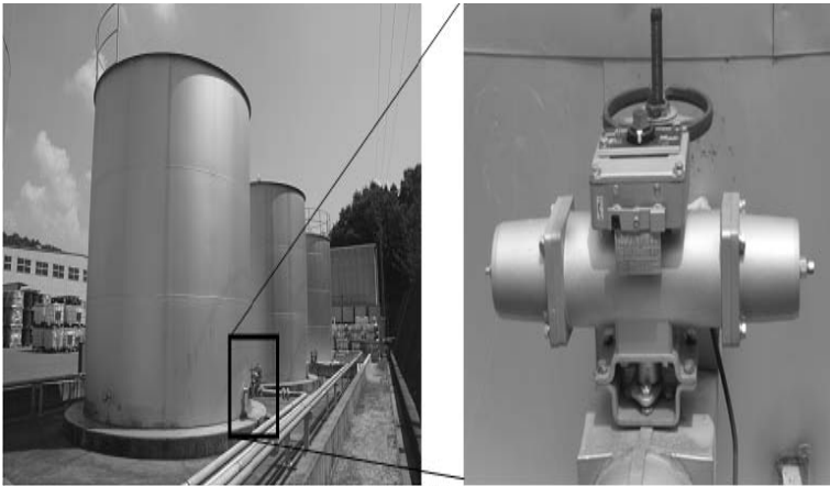
تصویر ۱: سامانه متوقف‌کننده و شیر متصل به مخزن مواد سمی (منبع: کازوآکی کوراهاشی و ایری کورا، ۲۰۰۸) ۱
